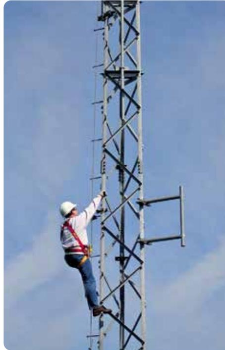
La torre SUPER TITAN KD es una torre modular robusta de fácil armado y transporte. Consta de 21 secciones de 3 metros cada una configurables según la necesidad del resistencia solicitados.
